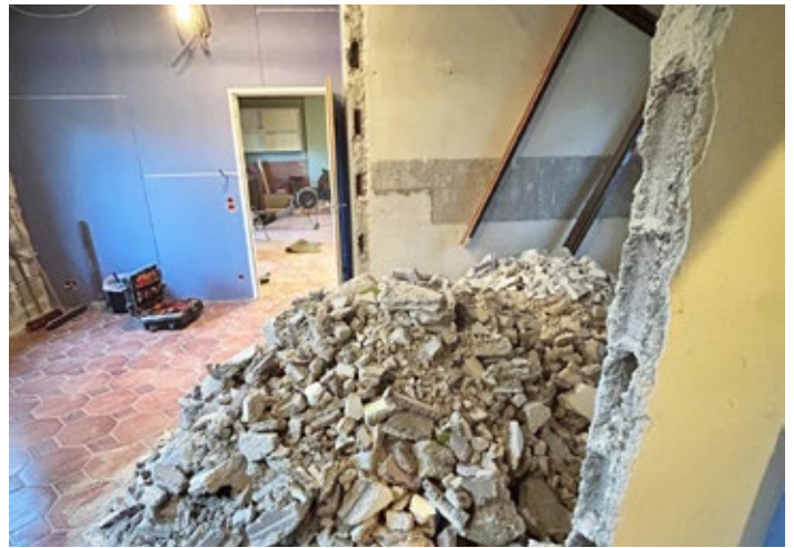
Viel Bauschutt nach dem Abbruch der Wände. Im Hintergrund ist schon die neue Trennwand im Trockenbau zum Trainingsraum zu sehen. Unten: Die neue Raumaufteilung mit der Küche wird sichtbar.
