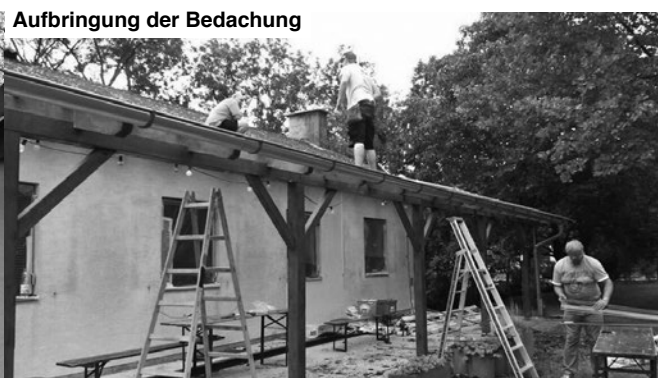
Aufbringung der Bedachung
